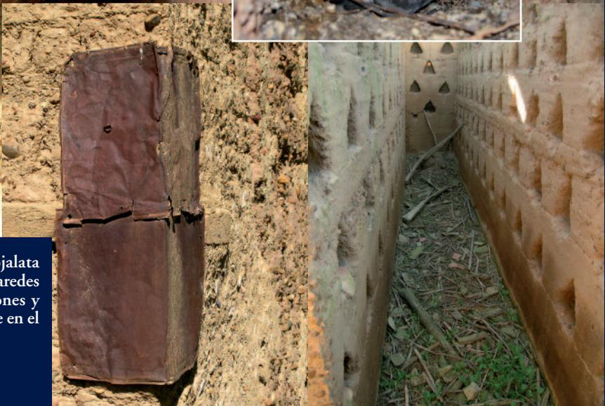
Casi todos los palomares tienen unas chapas de hojalata colocadas a media altura de los cuatro ángulos de las paredes exteriores. Su función es impedir que garduñas, hurones y otras alimañas puedan trepar hasta la cubierta y meterse en el palomar, "para que no aúñen", nos explica Mauricio.
