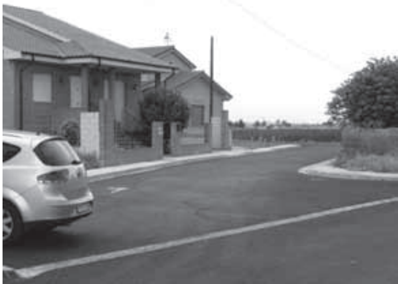
Asfaltado de una nueva calle en Villaquejida. Foto: J. M. Ámez
